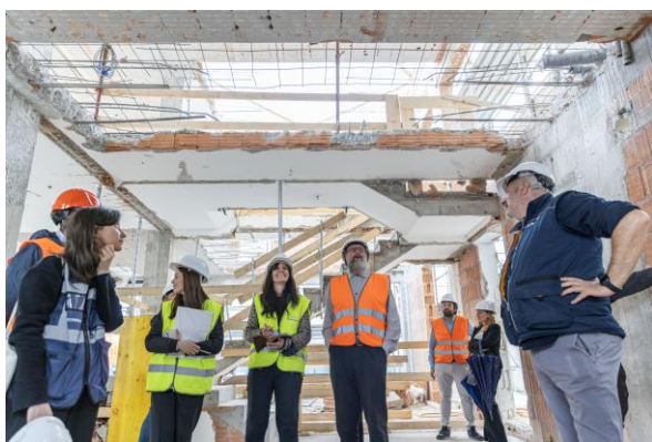
Foto di cantiere: demolizione delle partizioni interne
