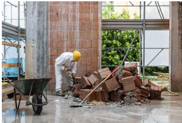
Foto di cantiere: apertura delle grandi superfici finestrate
