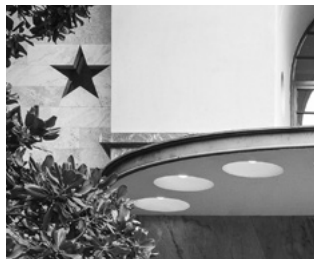
Die Fassade mit dem Detail der sternförmigen Öffnung
