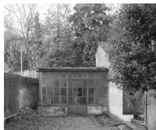
Das Treibhaus vor den Renovierungsarbeiten durch den FAI
