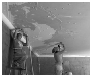
Die Restaurierung der Decke aus Stuck
