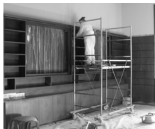
Die vom FAI durchgeführten Restaurierungsarbeiten
