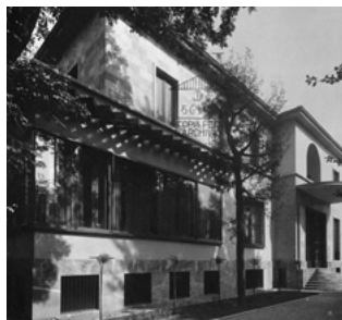
1935: Die Fensterfront der Veranda
