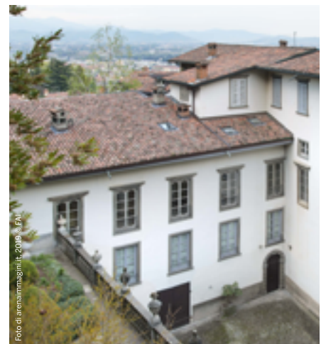
Una delle ali di Palazzo Moroni affacciata sulla corte
