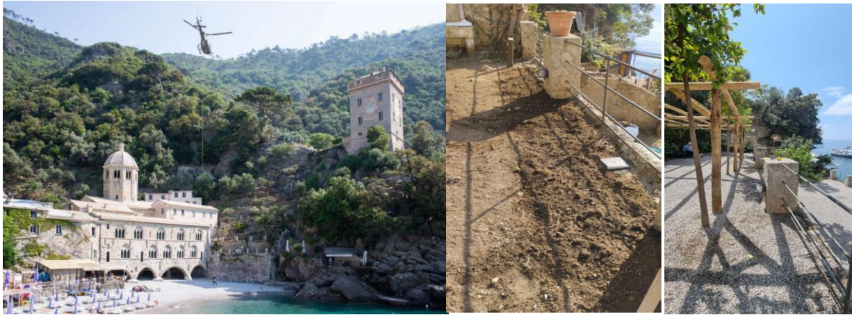
Veduta del Bene – Interventi di manutenzione straordinaria del muraglione del giardino dell'Abbazia
