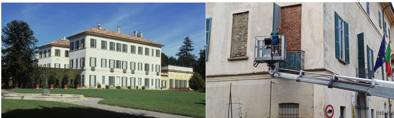
Il corpo di fabbrica della Villa visto dal secondo parterre del giardino - rimontaggio delle persiane del lato est della Villa
