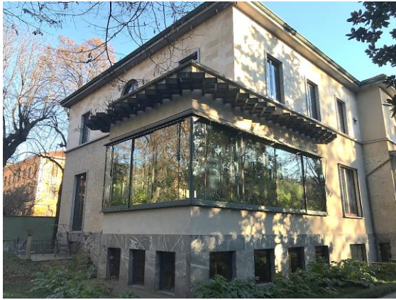
Vista del pergolato della Villa a sbalzo
