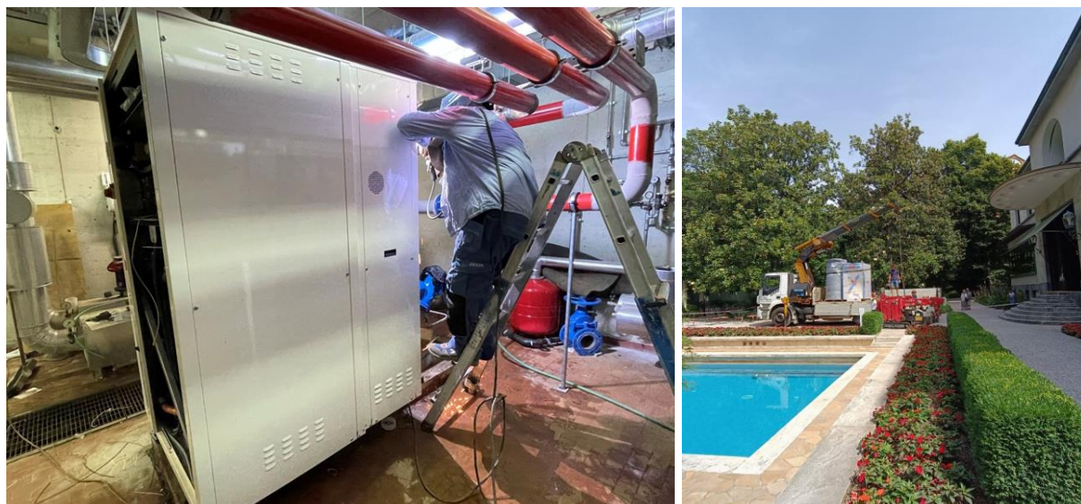
Installazione della nuova pompa di calore - trasporto e movimentazione
