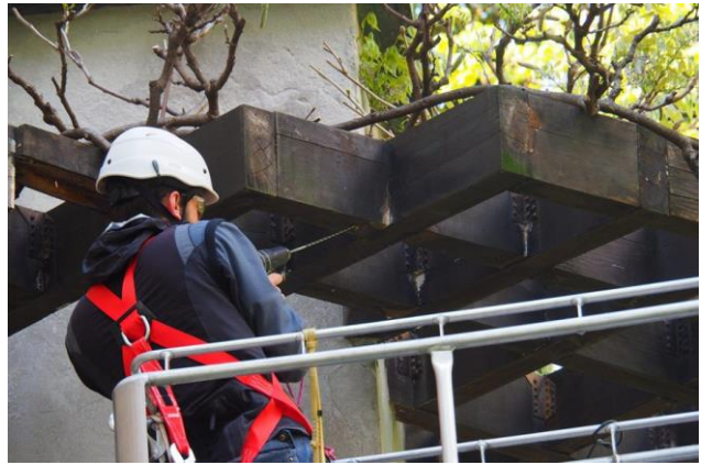
Intervento di messa in sicurezza del pergolato
