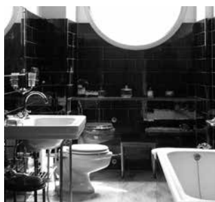
Il rivestimento in pasta di vetro del Bagno
