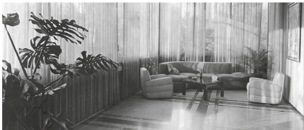
1935. L'aspetto originario della Veranda come da progetto di Portaluppi
