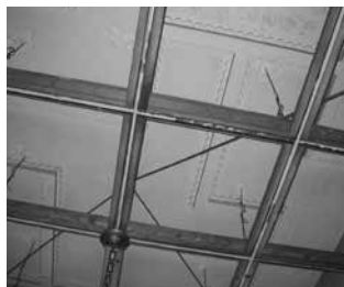
Il soffitto a labirinto di Portaluppi durante i restauri
