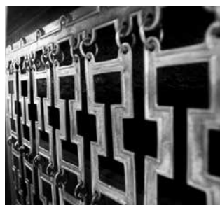
Dettaglio del copricalorifero dell'Office
