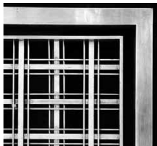
Dettaglio del copricalorifero della Hall
