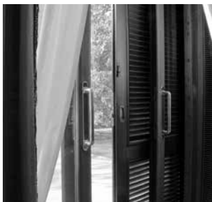
Un particolare del sistema dei serramenti
