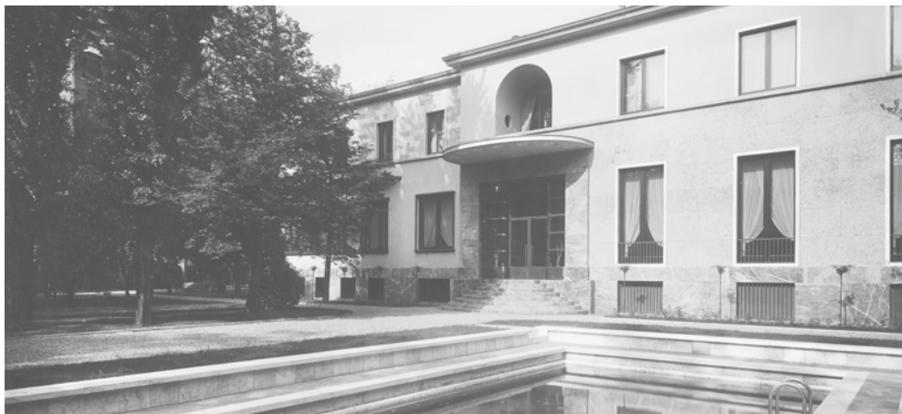
1935. La facciata e la piscina della villa
