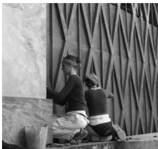
Le innovazioni tecniche: la grata metallica
