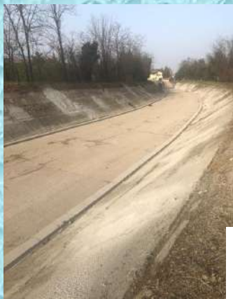
Pulizia e riparazione del fondo e delle sponde.
